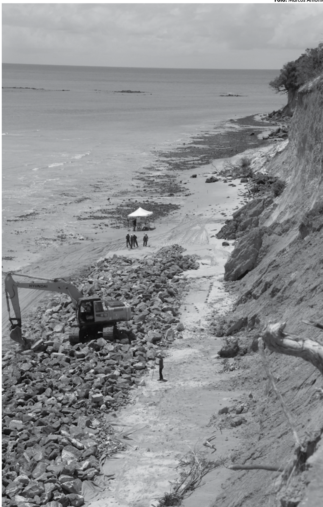
Obras na barreira do Cabo Branco preveem neste momento a drenagem e a colocação de pedras na base da falésia
