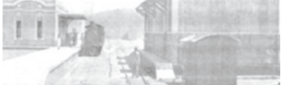
Estação de trem de Bananeiras, construída para escoar a safra de café da região, foi entregue quando a cultura já estava em declínio
